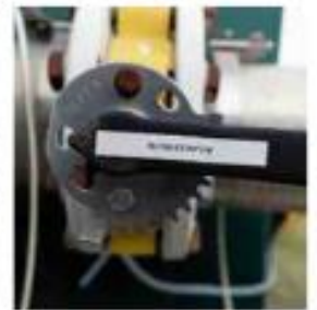
Kranen till gasen som går till tyska arméns mobiliseringsförråd.
