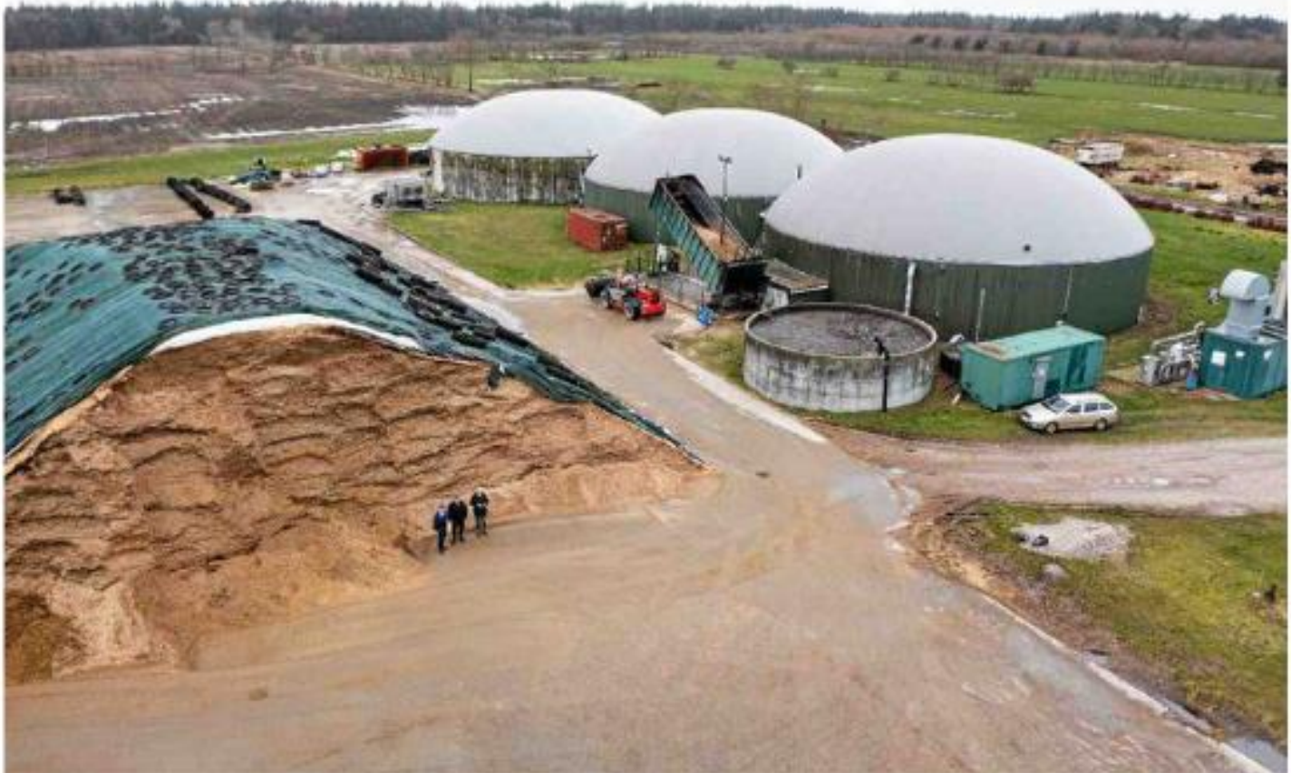
Biogasanläggningen ligger bara några hundra meter in i Tyskland.
